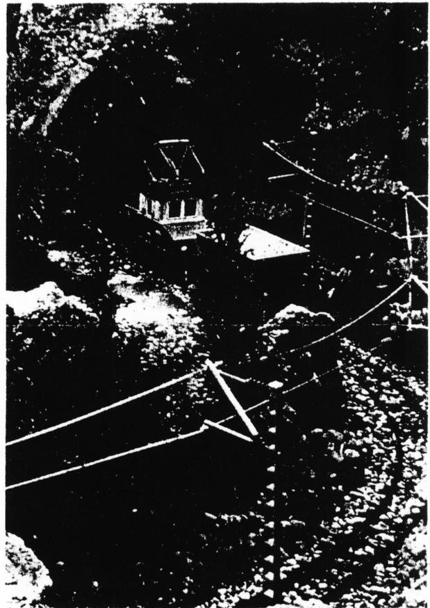
**Bild 2:** Tunnelausfahrt bergseits, E-Lok auf 6 % Talfahrt mit Stromrückspeisung
