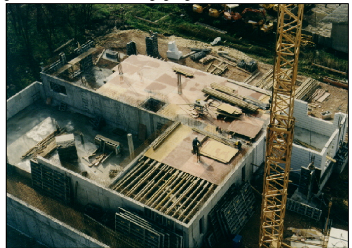
hier entsteht die neue Leitstelle
